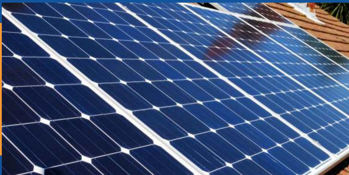
Essa conversão é realizada pelas chamadas **células fotovoltaicas**, compostas por material semicondutor, normalmente o silício. Ao incidir sobre as células, a luz solar provoca a movimentação dos elétrons do material condutor, transportando-os pelo material até serem captados por um campo elétrico (formado por uma diferença de potencial existente entre os semicondutores). Dessa forma, gera-se eletricidade.
